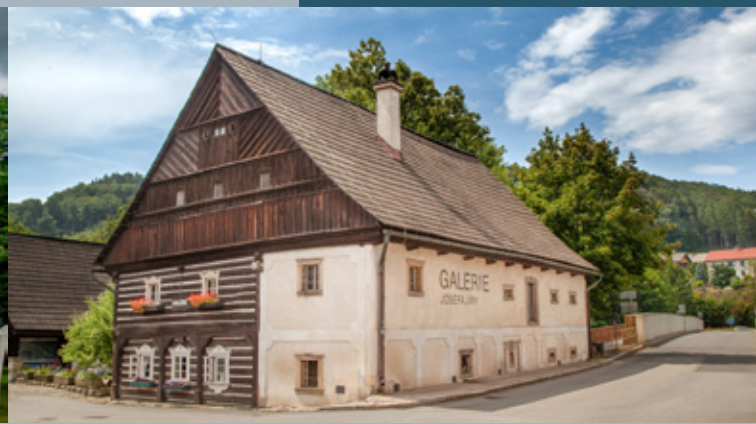
Boučkův statek na Malé Skále Bouček-Hof in Malá Skála
